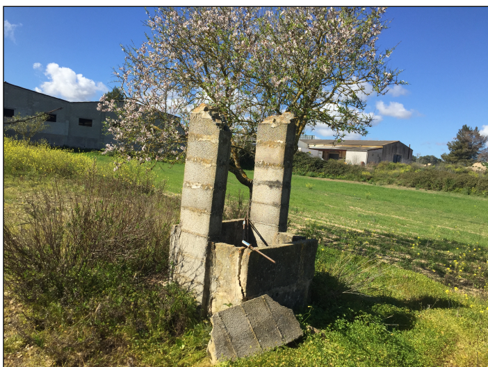
Pozo de marés, protegido por el PFO.
