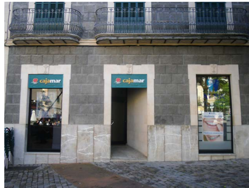
FOTO FACHADA ACCESO SUCURSAL PLAÇA DE LA VILA
